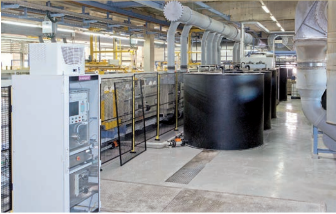
K-alpha (links) und Verdampferspeichertanks
