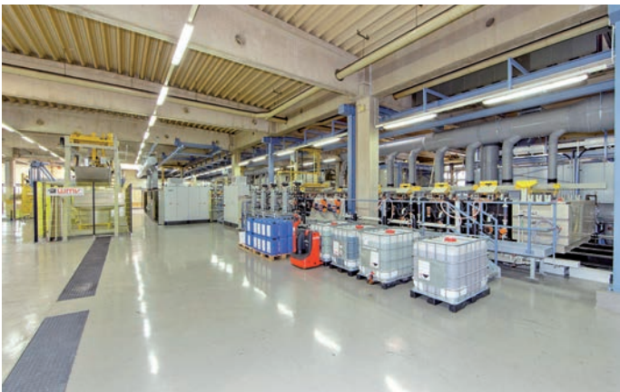
Gesamtansicht der Anlage
