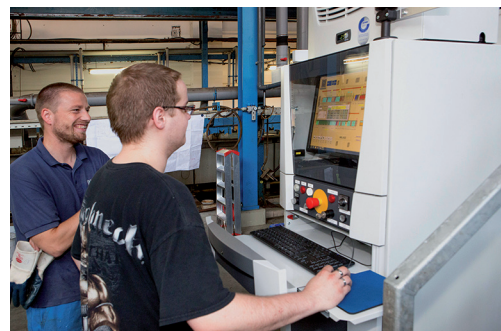
Abb. 4: Eingabepanel der Anlagensteuerung
